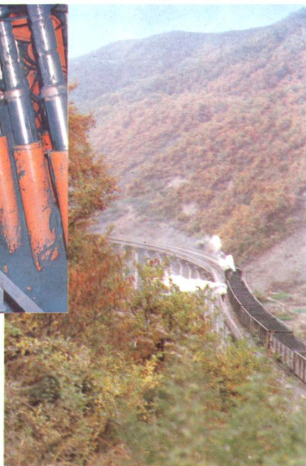
▲运煤铁路专用线
