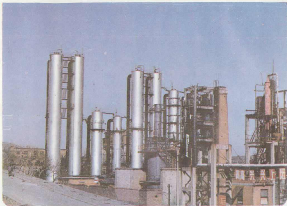
精苯车间一角
