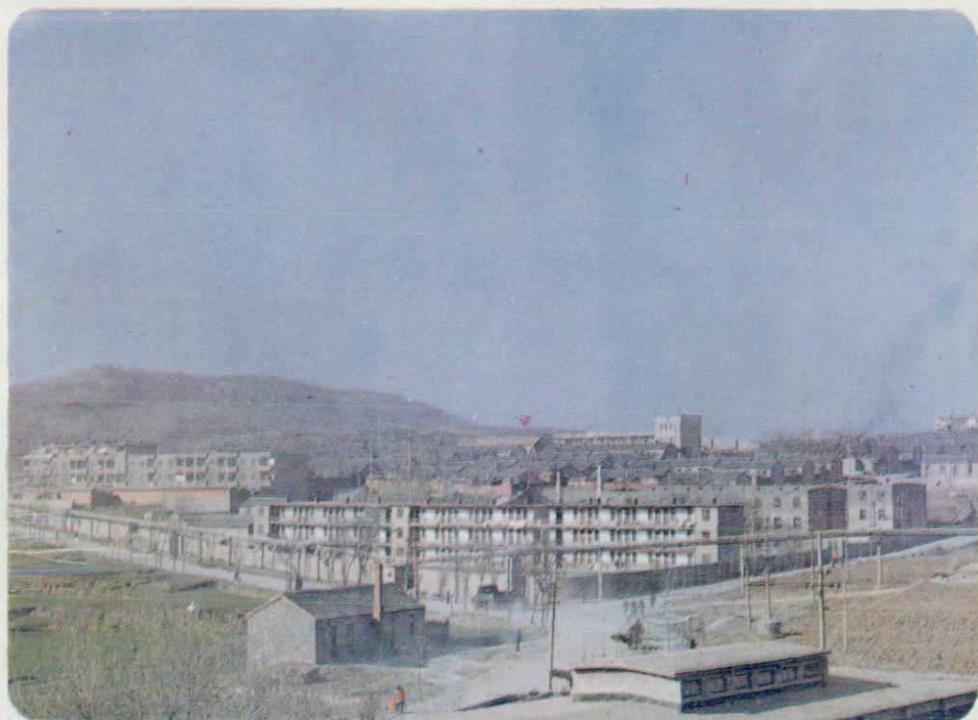
焦化厂生活区全貌
