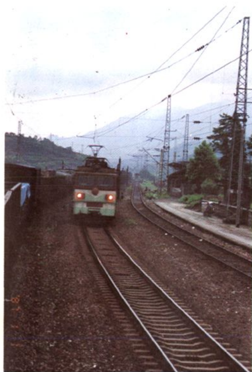
23. 鹰厦铁路电气化资溪路段
