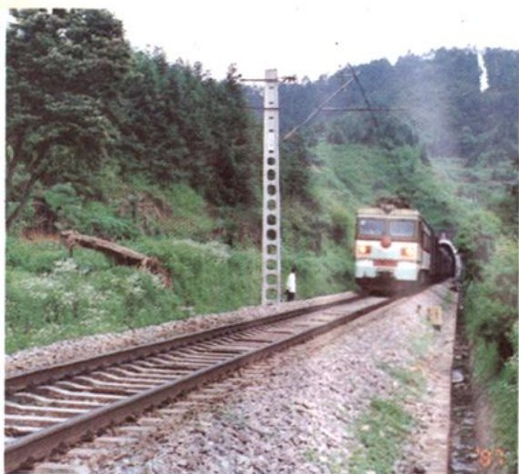
21 妙嘴坳铁路隧道
