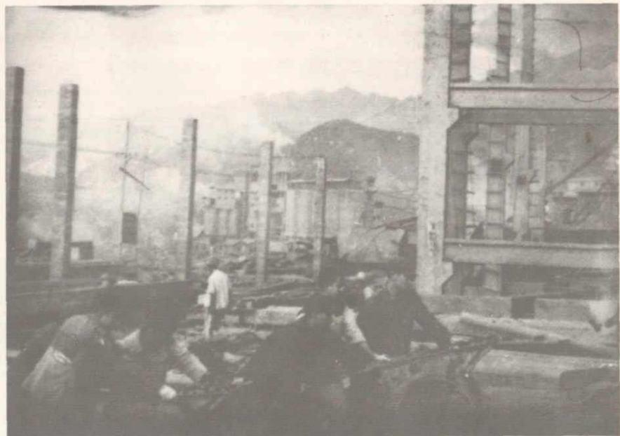
▼ 1971年工厂扩建一号旋窑工地
