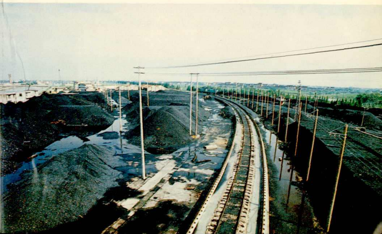
石塘湾煤栈卸煤铁路专用线
