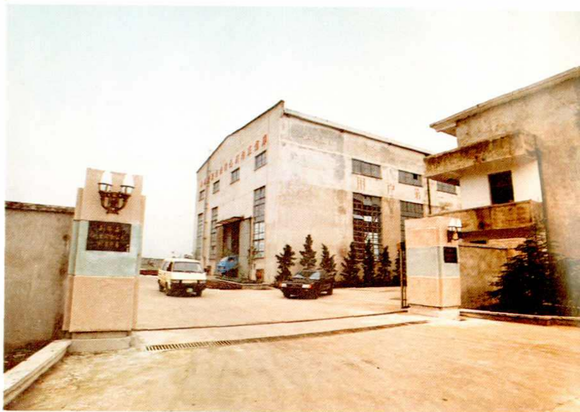
柏庄机电设备库
