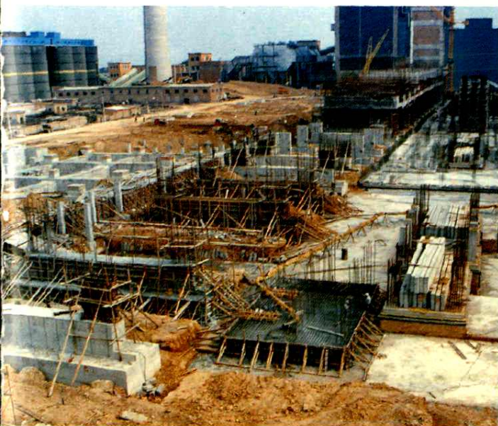
二期工程施工现场
