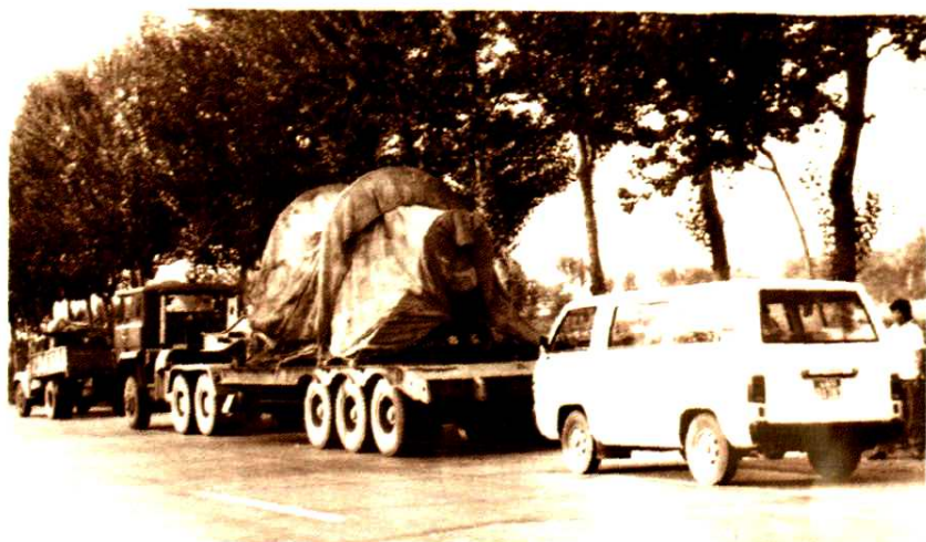
1987年7月,1号机低压转子 返制造厂修理
