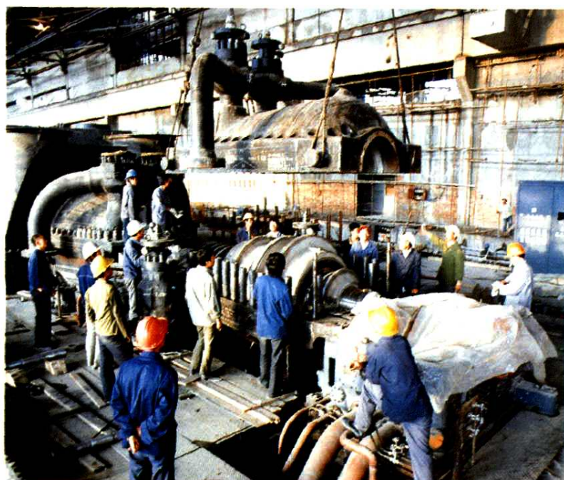
3号机大修现场
