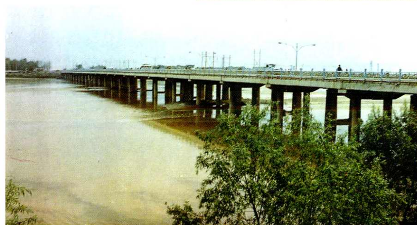
咸阳渭河大桥
