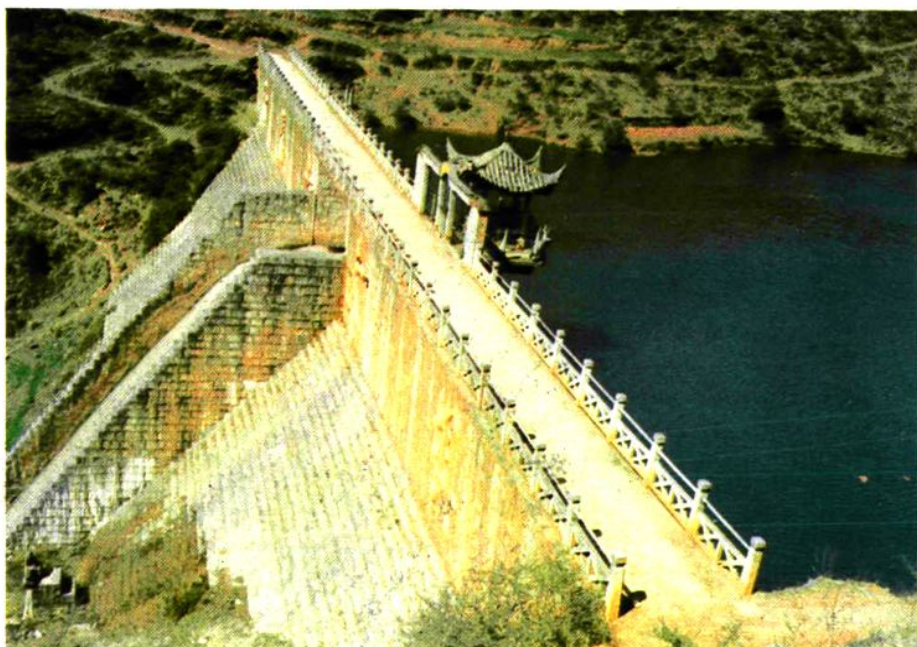
竹荪河砌石重力坝
