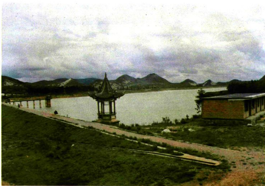
小石山水库全貌
