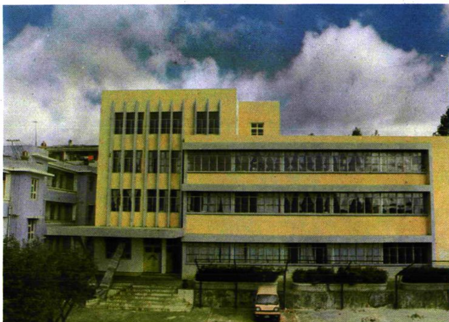
水电局机关办公楼
