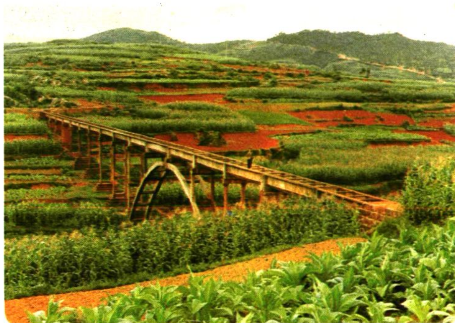
东风水库二号渡槽
