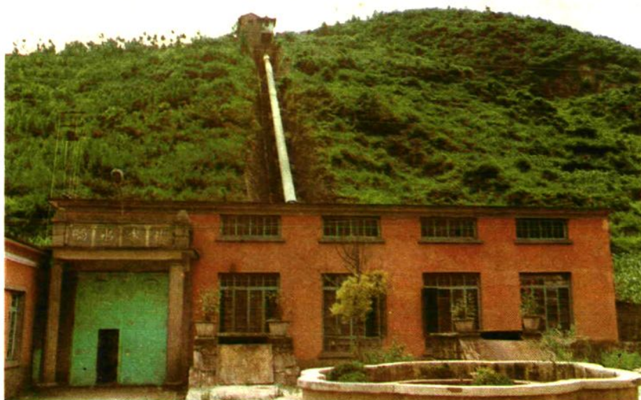
响水电站厂房
