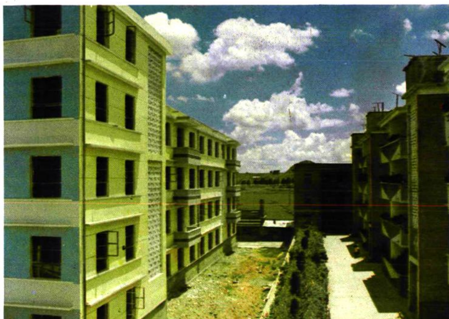
电力公司办公楼 宿舍
