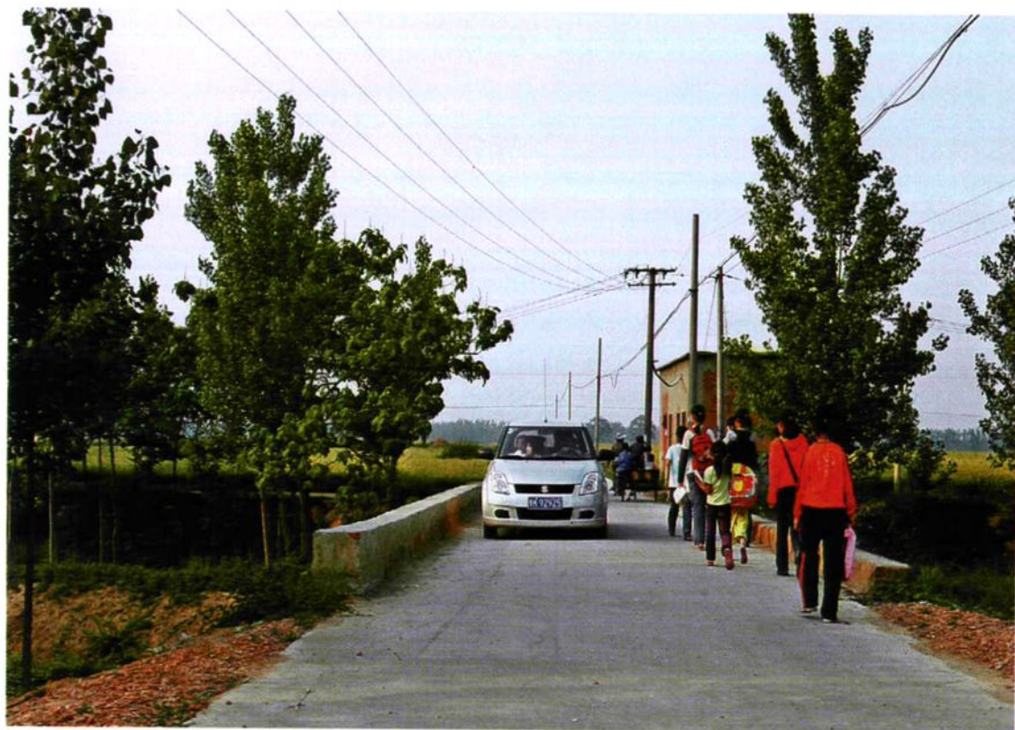
岗张——范寨小公路
