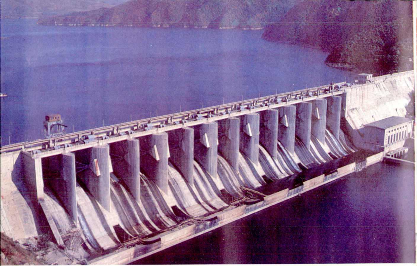
参窝水库混凝土重力坝
