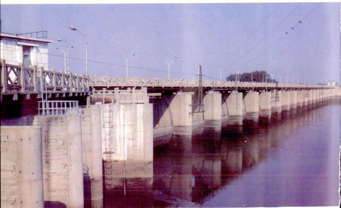
浑河拦河大闸
