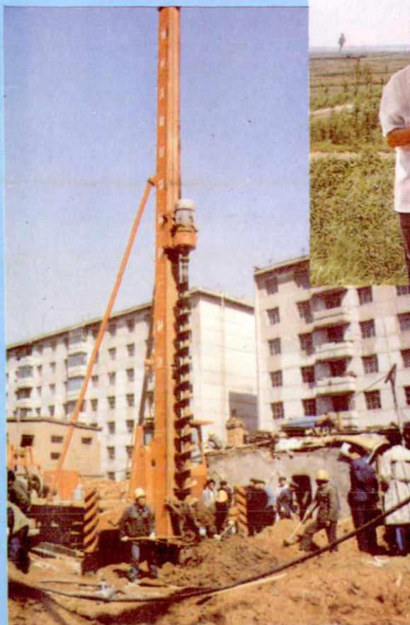
螺旋桩基础施工
