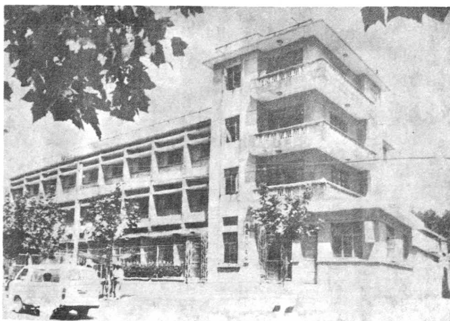
来安县供电局大楼
