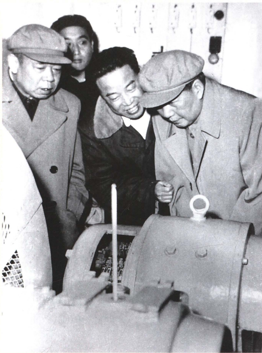
1960年4月,全国农业发展纲要正式发布。纲要要求“凡是能够发电的水利建设,应当尽可能同时进行中小型的水电建设,结合国家大中型的电力工程建设,逐步增加农村用电”。图为1960年3月14日,毛泽东主席视察浙江省金华县双龙人民公社水电站。
