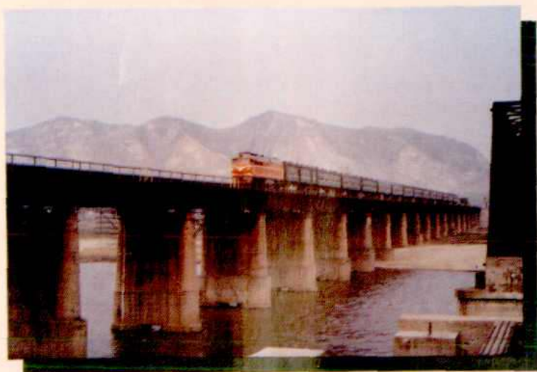
滦河铁路大桥
