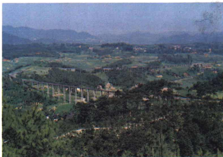
巧英水库西山渡槽
