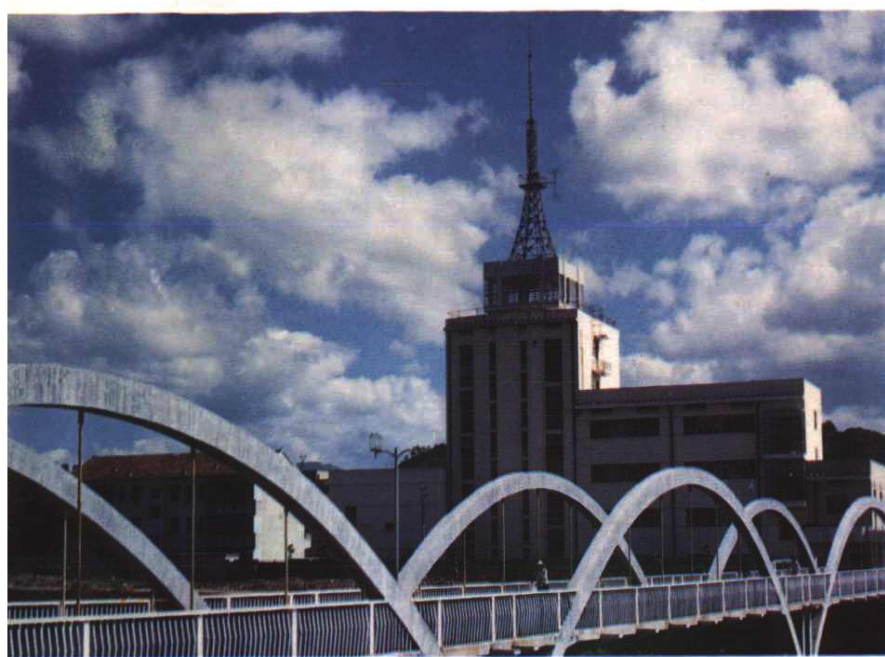
广播电视大楼
