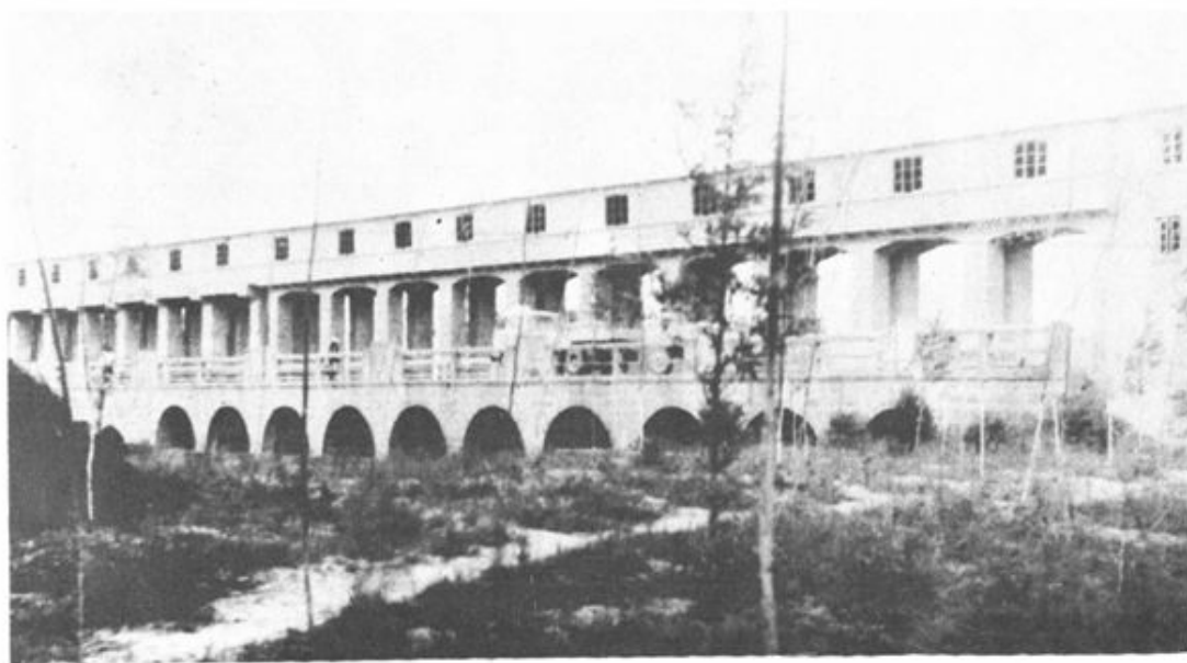
四铺区水利枢纽工程：以闸带桥的四铺大坝全景。全闸20空，长107.2米，宽7米。
