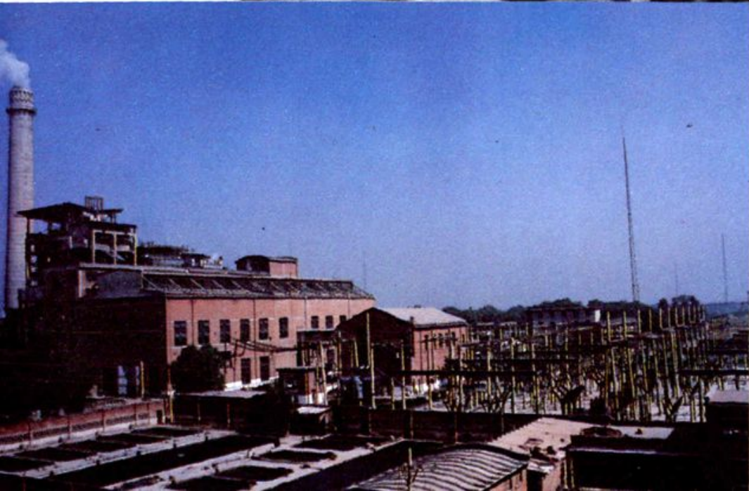
老厂主厂房升压站
