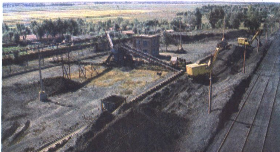
孟家屯供应站混配煤生产线
