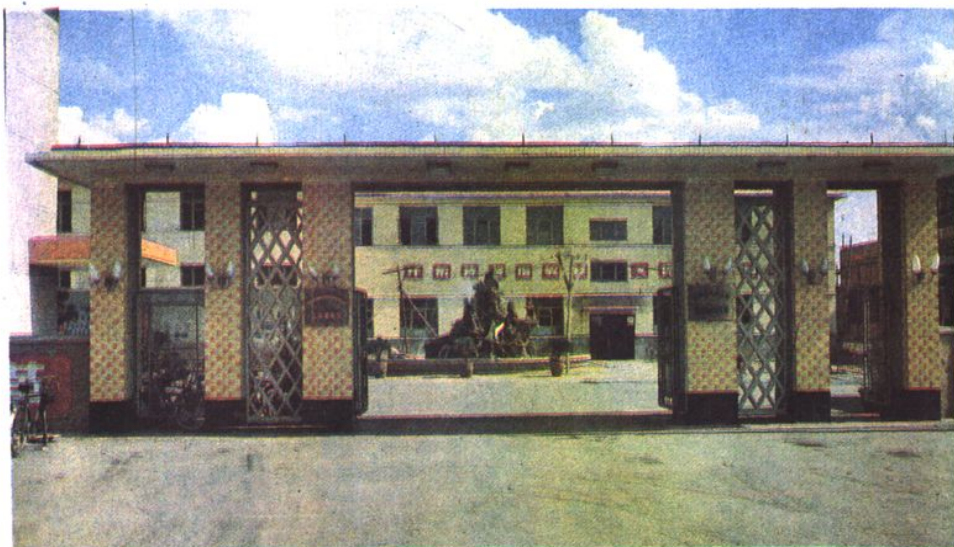
东站煤炭供应站
