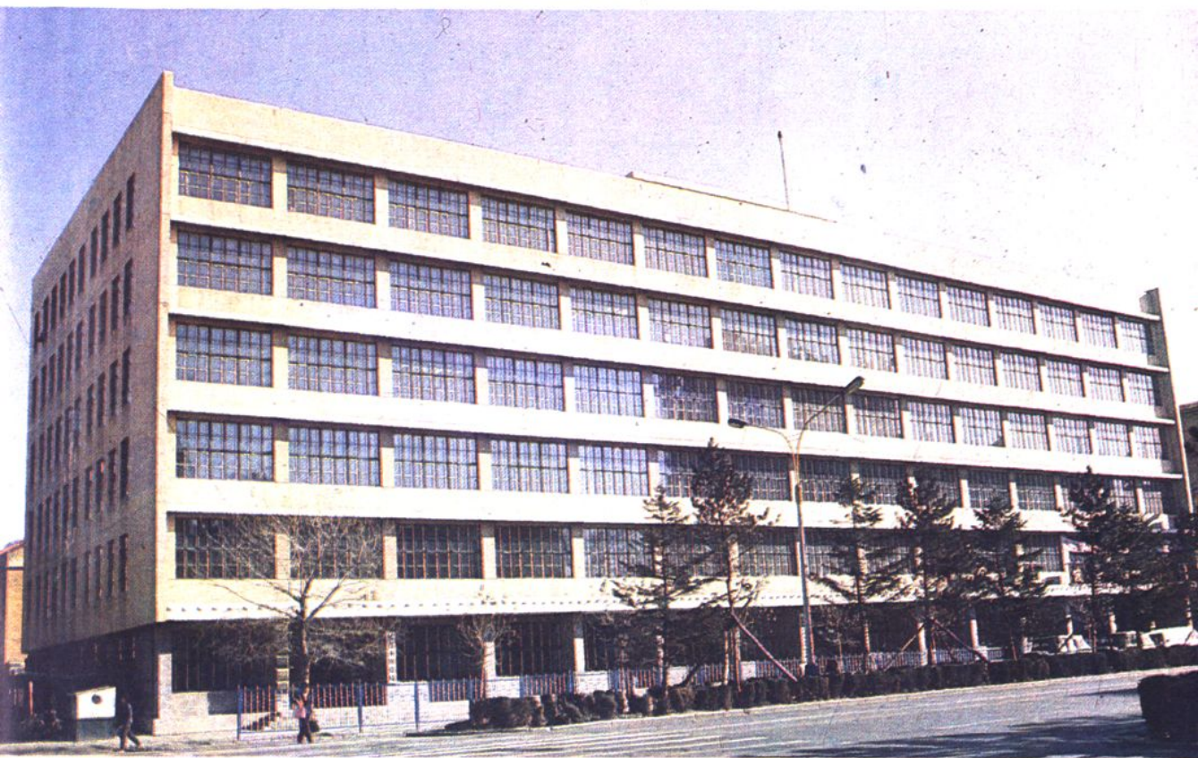
公司办公大楼（斯大林大街62号）
