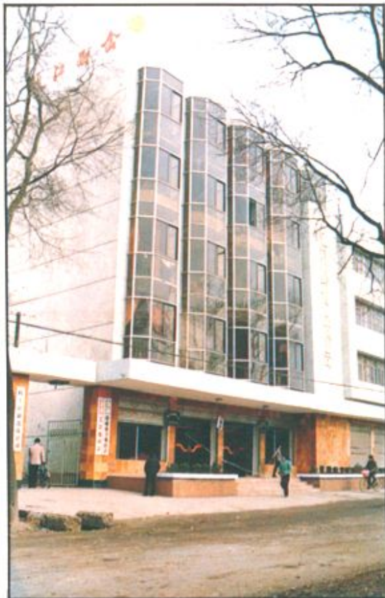
副食品公司办公大楼
