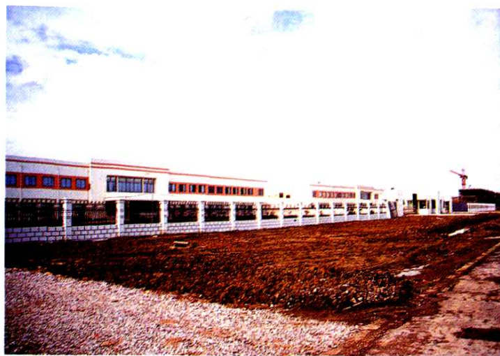
吴江市开发区建设用地整理
