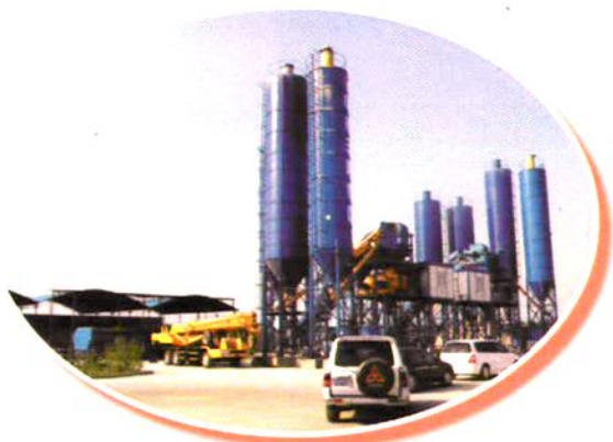
混凝土搅拌站
