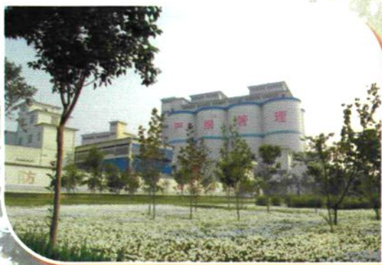
水泥二厂粉磨站
