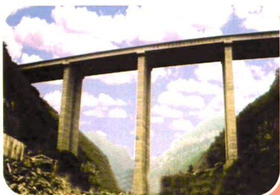
焦晋高速公路上亚洲第一高桥—大登桥
