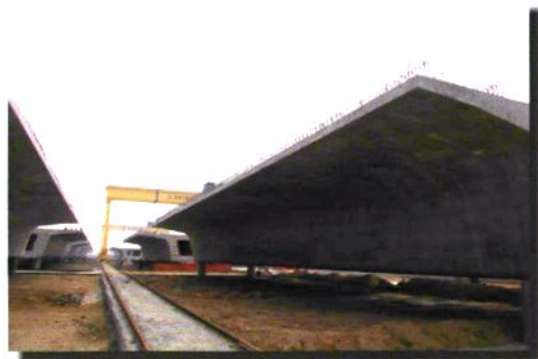
西合线上大型预应力梁
