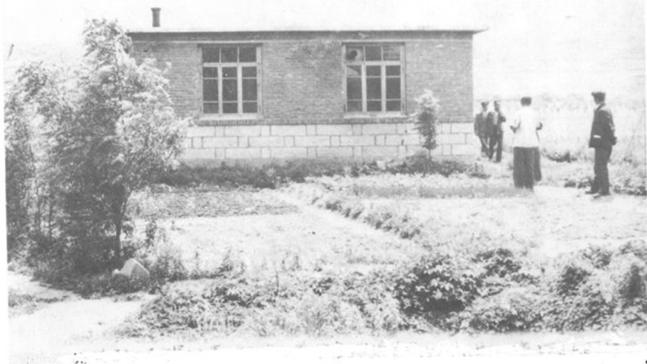
为控制地方性氟中毒，1982 年以来国家拨给盖县 15 万元，共打防氟深井七眼，这是陈屯乡上枣峪村防氟深井房。
