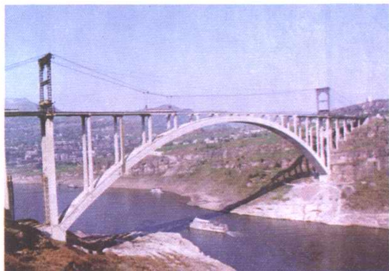
万县长江公路大桥
