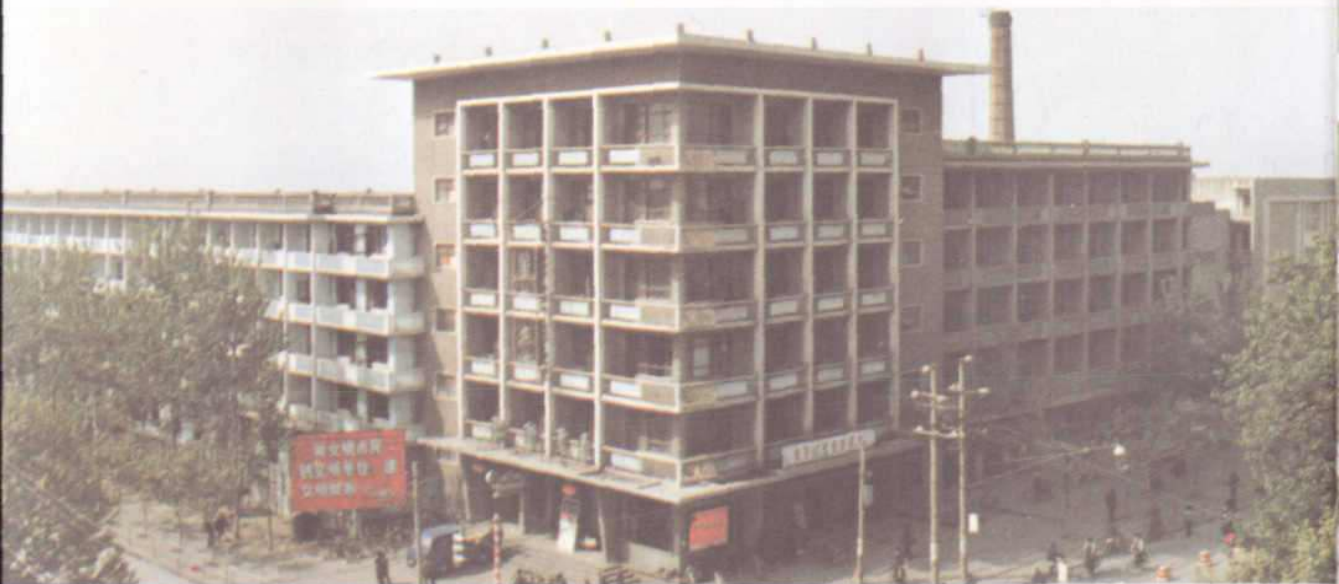
焦作宾馆楼是焦作市进行墙体改革后第一次使用煤矸石空砌块的试验楼(1977年建成)
