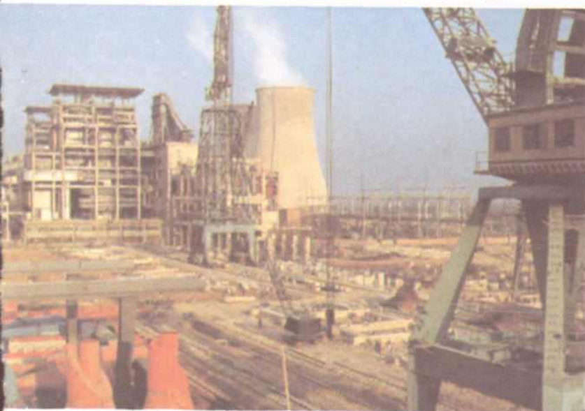
正在建设中的焦作电厂
