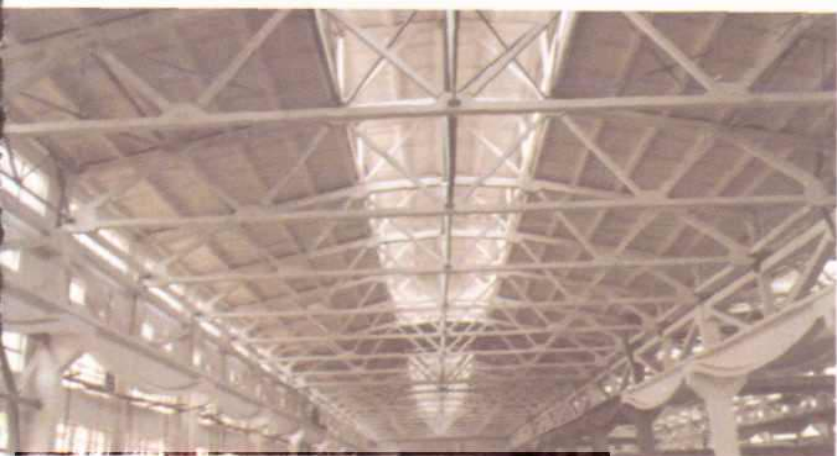
↑ 河南轮胎厂巨胎车间内部结构 → 焦作电厂210米高的烟囱
