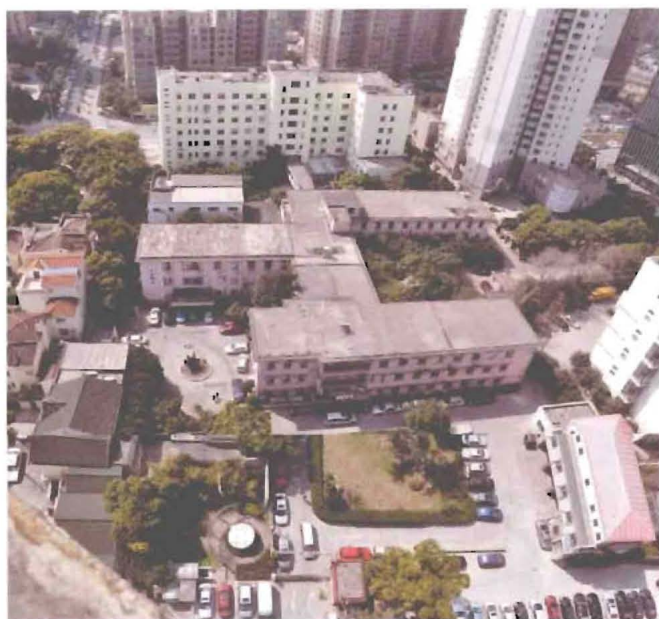
新一轮改扩建前的民航上海医院全景 (2011年9月1日)
