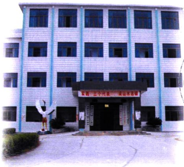
▲ 政府办公大楼
