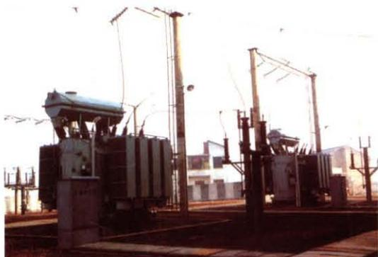
全路最先进的牵引平衡变压器
