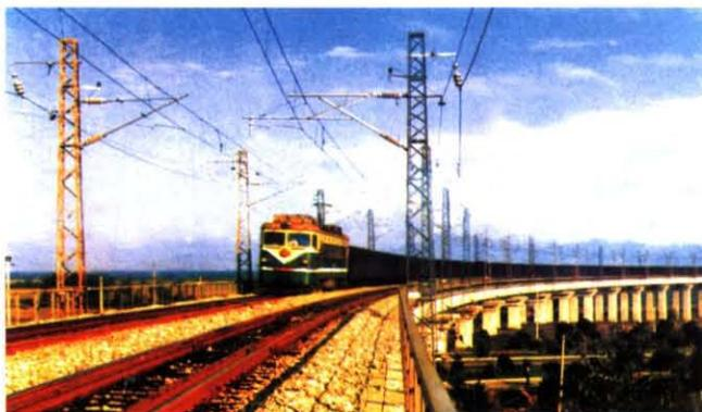
大秦线重载双线电气化铁路
