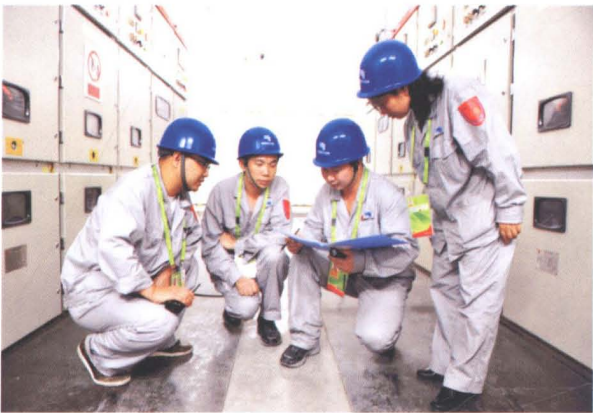
遵义电网控制室
