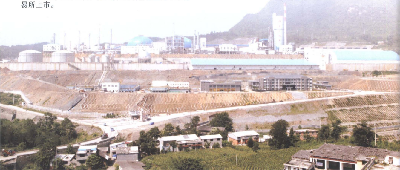
桐梓煤化工项目（一期）于2007年8月28日正式开工，一期工程总投资约35亿元
