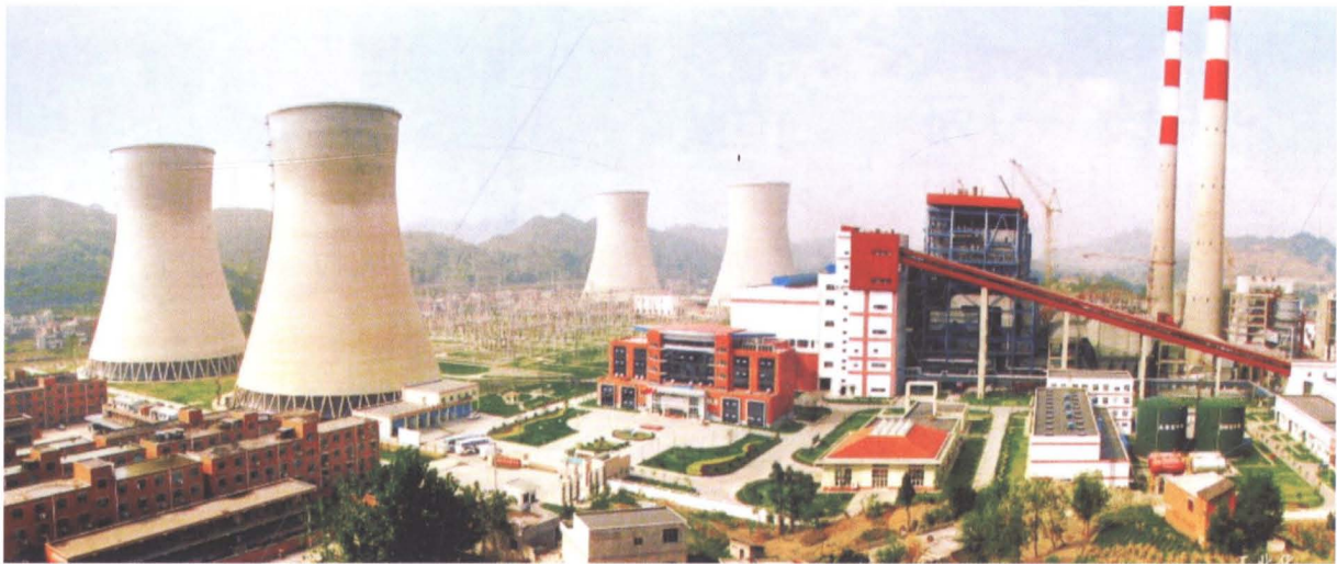
鸭溪发电厂2002年开工建设，总装机容量120万千瓦。2006年，鸭溪电厂实现4台机组并网发电
