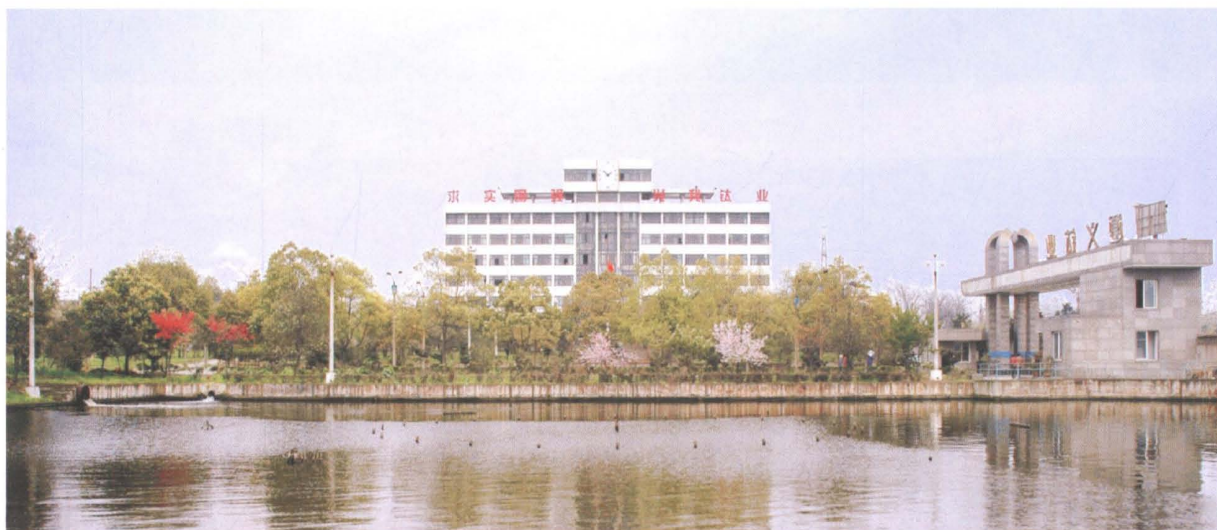
遵义钛厂厂区
