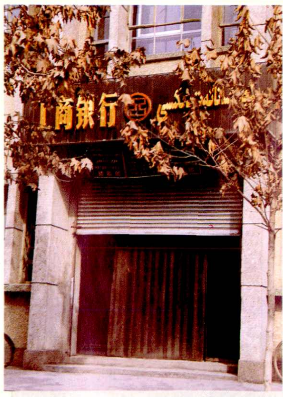
中国工商银行沙雅县支行办公楼
