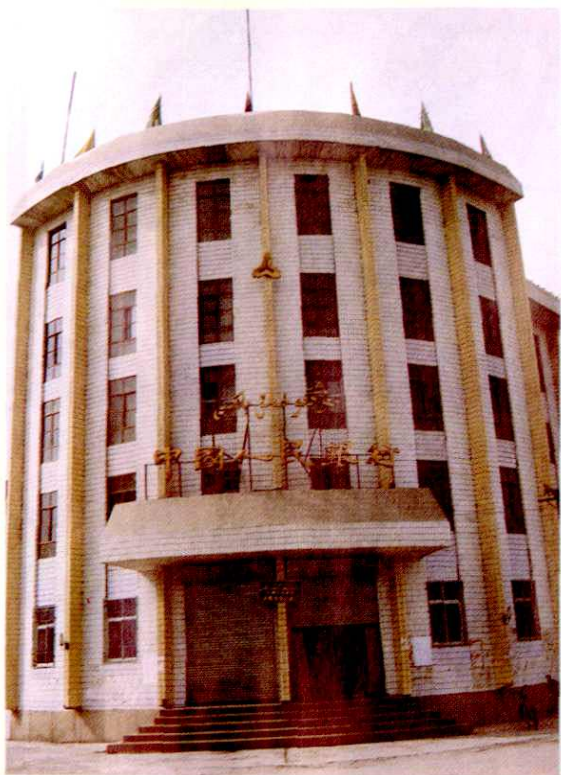
中国人民银行沙县支行办公楼
