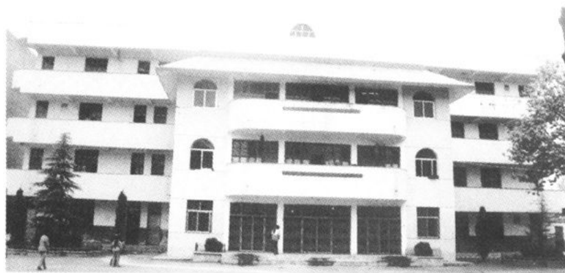
三店二中综合楼
