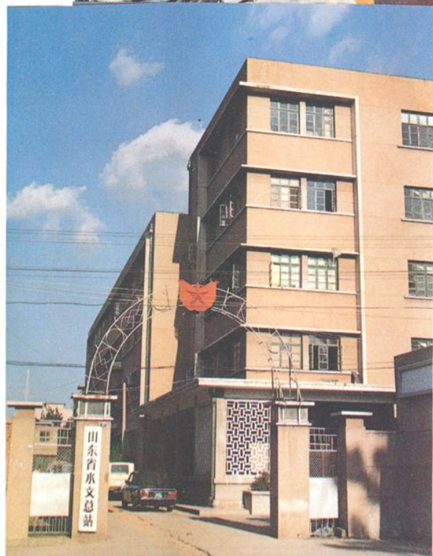
山东省水文总站办公大楼
