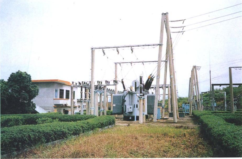
阳春110千伏春湾变电站（主变20000千伏安1台）
