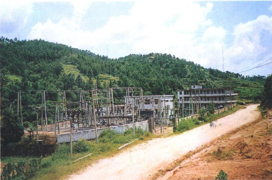
阳春110千伏圭岗变电站（主变10000千伏安1台，7500千伏安1台。）
