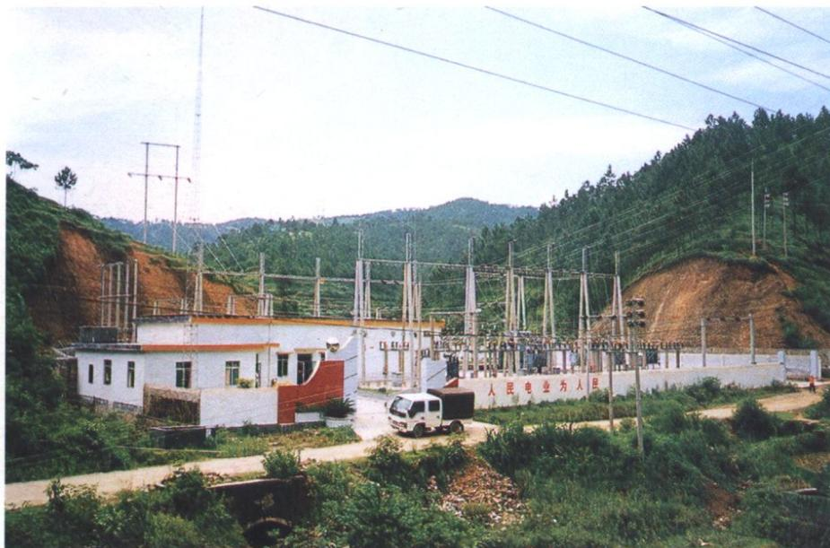
阳春110千伏山坪变电站（主变31500千伏安1台）
