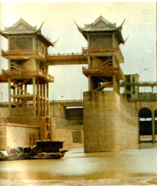
图为东流大闸
