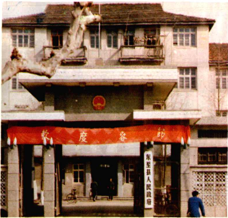
县人民政府办公楼
