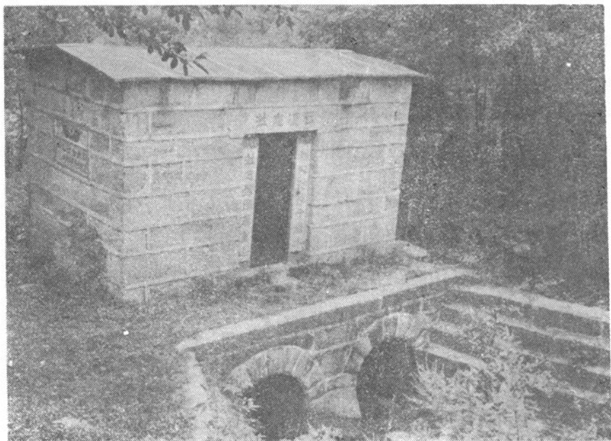
石垭子分水闸
