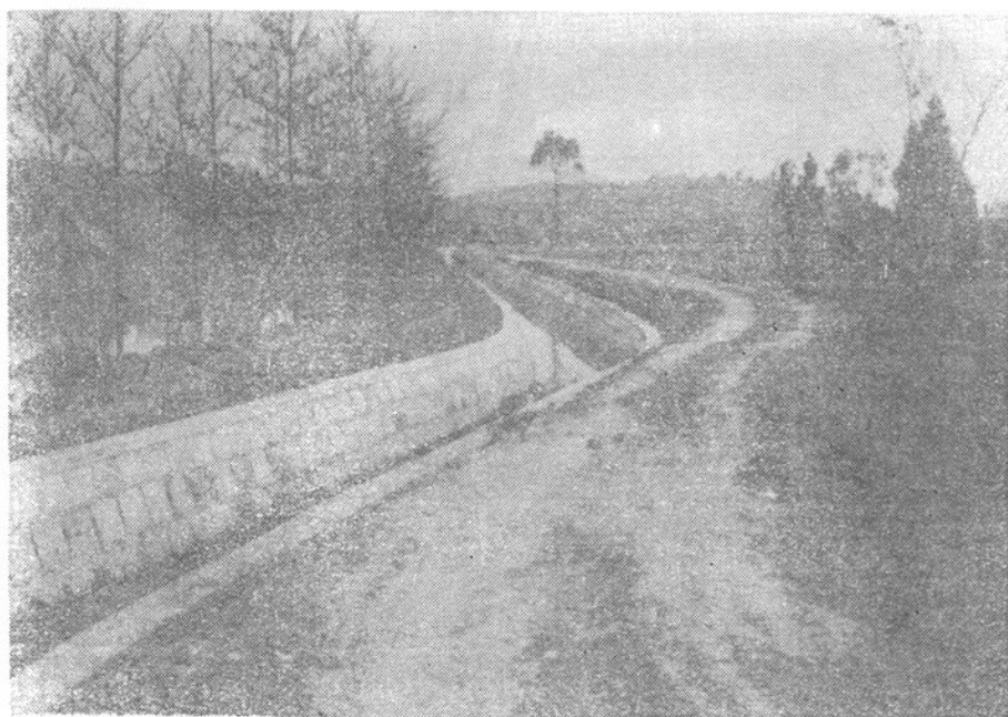
右支渠聂家堰防渗段
