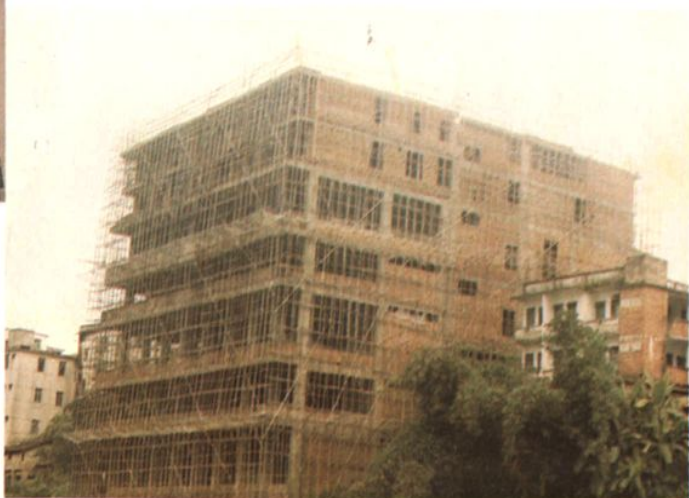
正在兴建的马江市场大楼→
