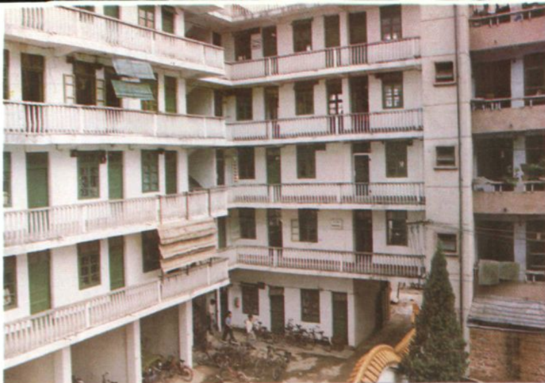
县局办公大楼外景。
