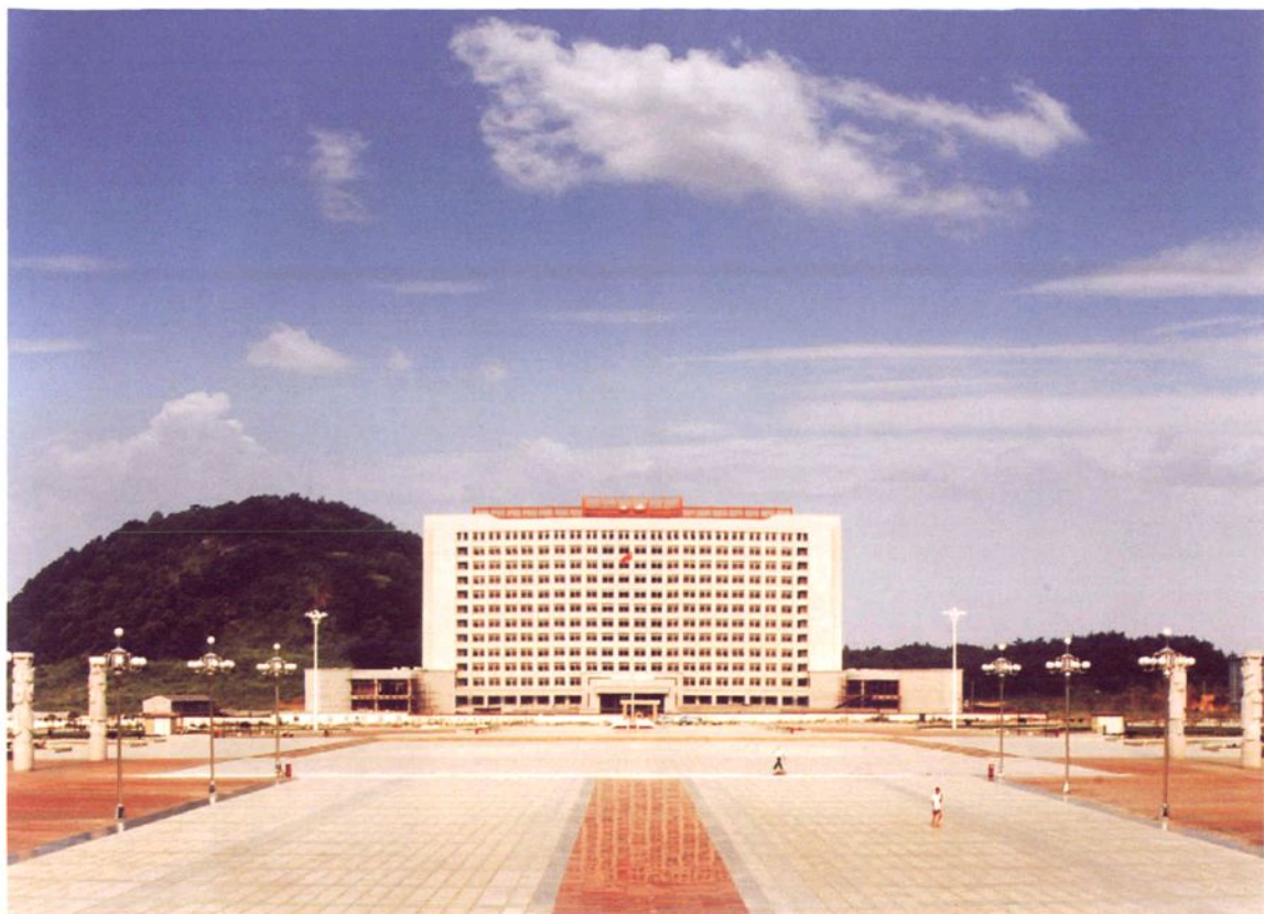
新落成的县行政中心大楼。
