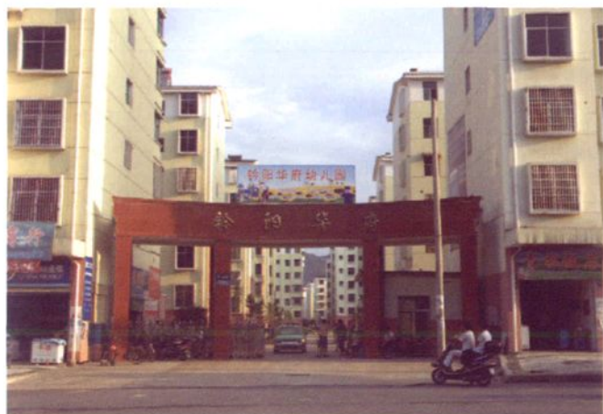
铃阳华府住宅小区
