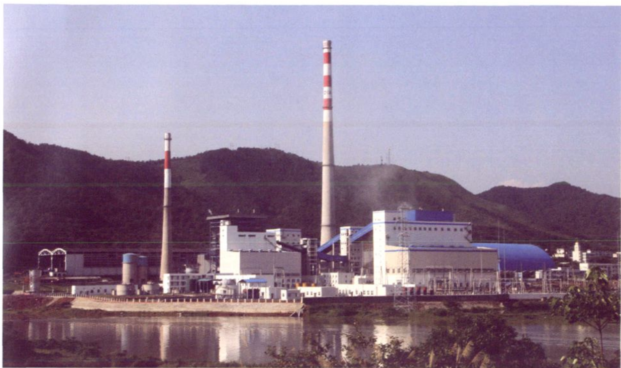
分宜发电厂首台国产210mW循环流化床机组厂区
