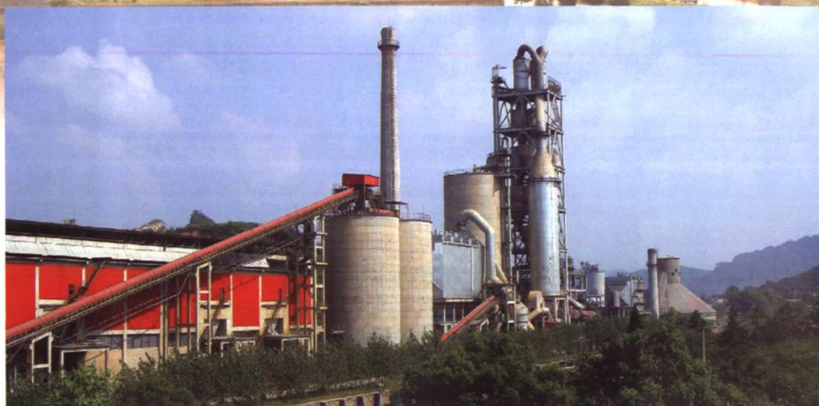
分宜海螺水泥有限公司新型水泥干化熟料生产线
