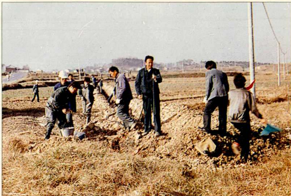
1991年10月，沪宁光缆句容段施工现场
