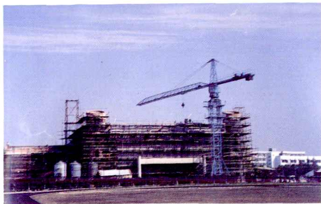
即将完工的文体中心
