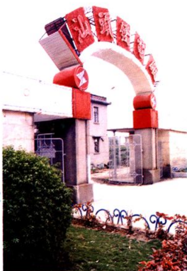
① 汕头发电厂（原汕头电力厂 4x1500 千瓦，1964 年建成，1986 年停产）。
