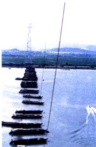
（●）1995年220千伏榕江大跨越工程在进行封航跨江架线。
