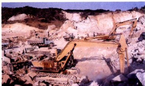
1995年500千伏汕头变电站进行场地平整。
