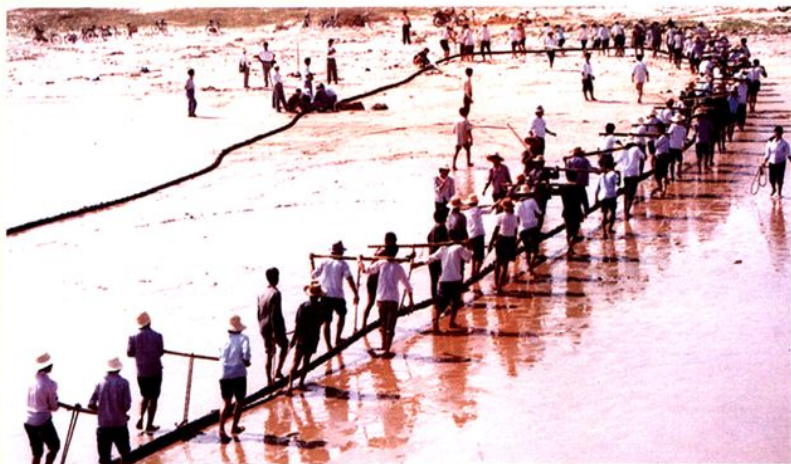
1995年南澳110千伏海底电缆施放现场。
