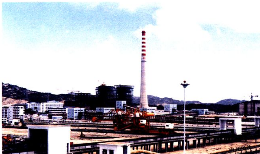
● 建设中的华能汕头电厂（2X30万千瓦）。
