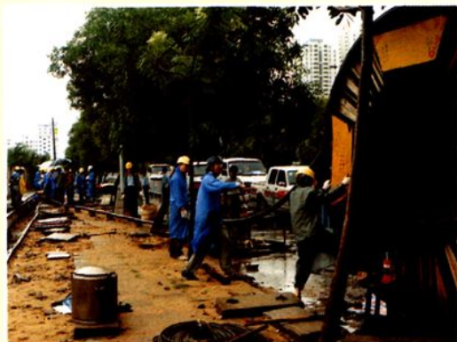
110千伏电缆敷设。
