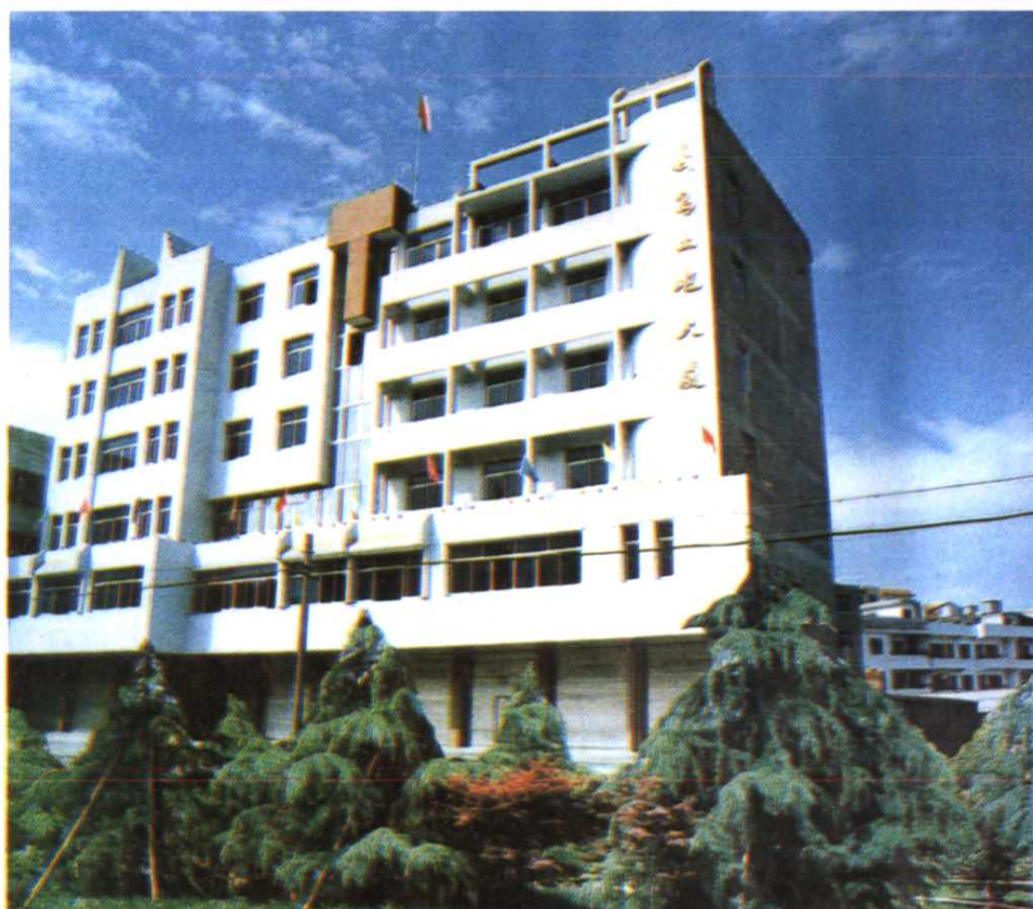
市土地管理局办公楼——土地大厦
