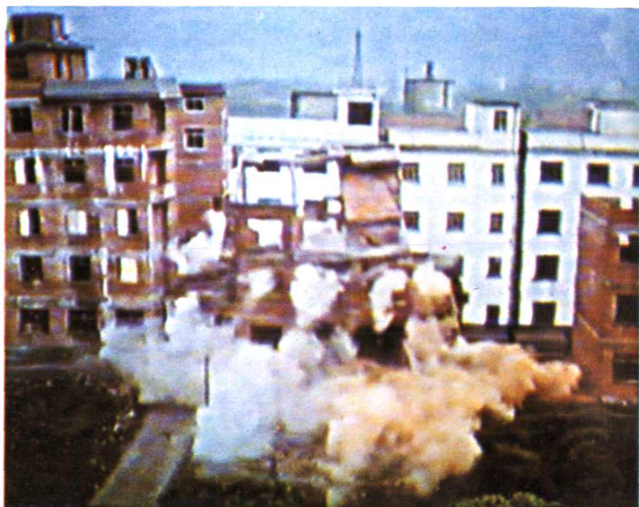
对城区违法占地的建筑物采用定向爆破拆除
