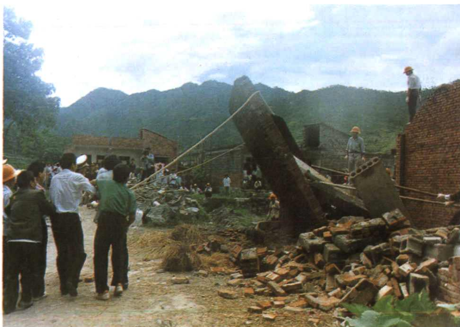
1989年，市土地管理局对原塘李乡××村方××的违法占地建筑物正在拆除
