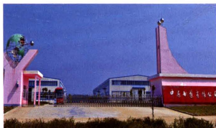
中原制浆有限公司
