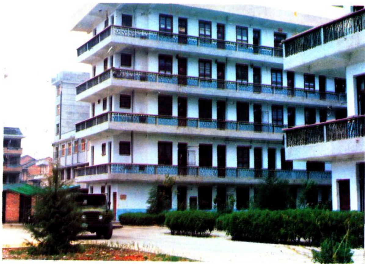
县支行办公楼一角。
