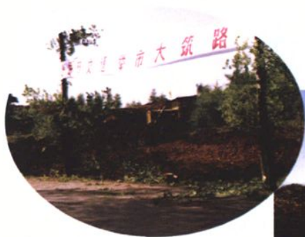
大筑路工地一角
