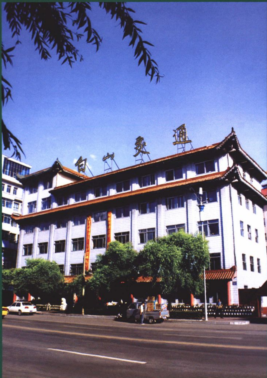
白山市交通局办公大楼
