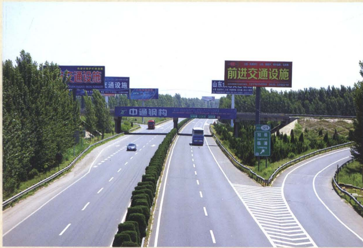
立体交通——公路立交桥俯瞰
