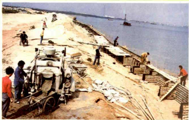
▲ 建设中的防洪大堤
