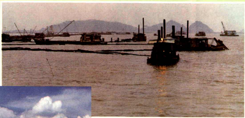
▲ 断波截流建绿洲——围垦工程一角
