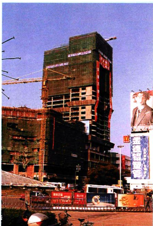
由湖南省醴陵建设集团施工的株洲市海惠国际商厦,高30层,建筑面积:36201m 2
