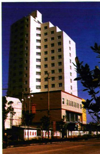
由湖南省醴陵建设集团承建的醴陵市金叶大厦,高 15 层,总建筑面积 16800m 2
