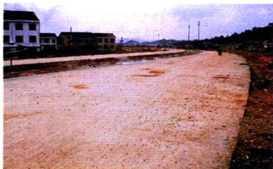
小区主干道砼路面已经完成。
