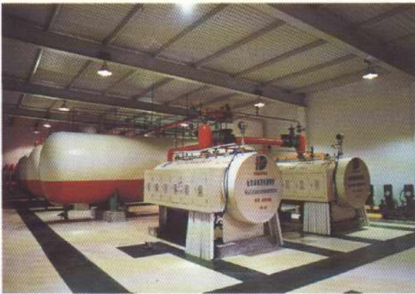
上图. 绿色环保微机控制电采暖锅炉。
