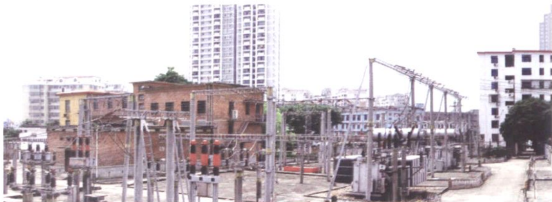
110千伏筱塘变电站(主变压器2台, 容量10万千伏安。1979年9月投运。1987年第一台主变压器增容改造, 1997年11月第二台主变压器增容改造)。该站为莆田市第一座110千伏变电站
