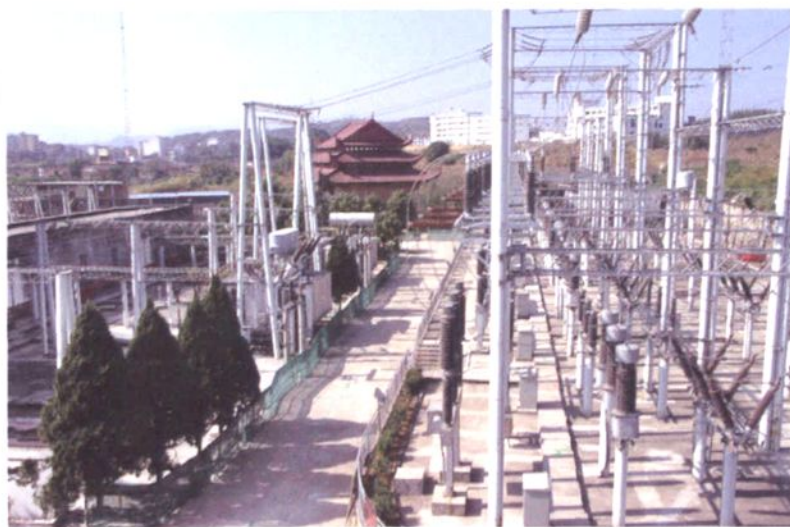
110千伏筱塘变电站(主变压器2台, 容量10万千伏安。1979年9月投运。1987年第一台主变压器增容改造, 1997年11月第二台主变压器增容改造)。该站为莆田市第一座110千伏变电站
