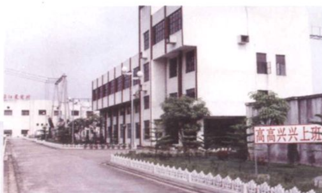
220千伏涵江变电站(主 变压器2台，容量36万千伏 安。1992年10月第一台主变 压器投运，2000年12月第二 台主变压器投运)。该站是 莆田市第二座220千伏变电 站
