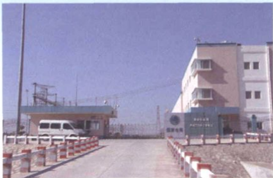
220千伏东进变电站(主变压器1台, 容量18万千伏安。2007年8月投运)。该站是莆田市第五座220千伏变电站
