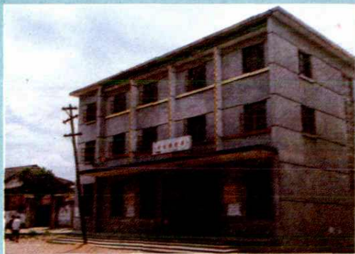
升坊糧管所辦公兼食品營業樓
