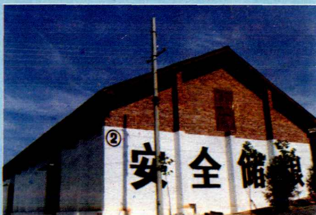
配有地槽機械通風倉
