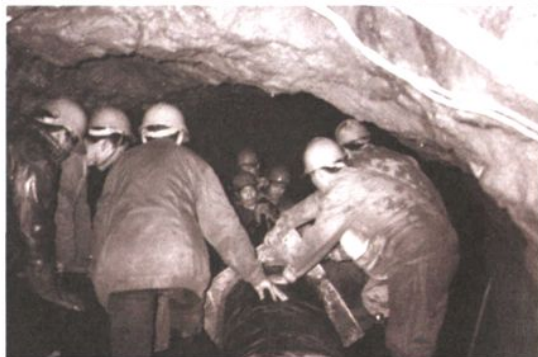
1998年12月22日7时，莱芜铁矿业庄矿区-52米水平突发涌水。经过10天的全力抢救，涌水得到成功治理。图为职工在全力排水。
