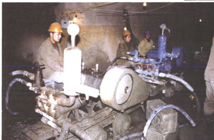
2003年2月28日，莱芜矿业有限公司业庄铁矿北部矿床注浆工程全面展开。图为井下注浆现场。
