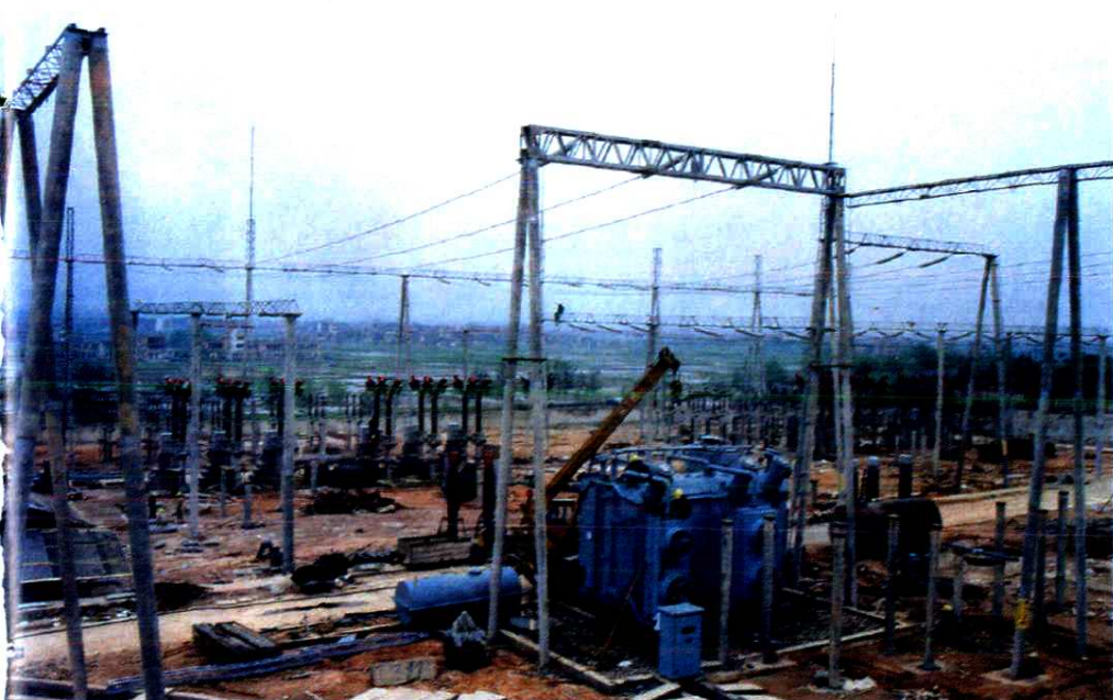
正在建设中的 220 千伏东阳变电所
