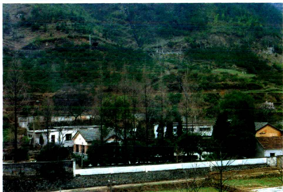
金华双龙水电站外景
