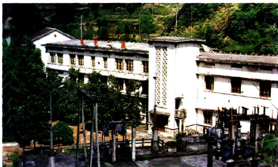
武义麻阳梯级水 力发电站的二级电站
