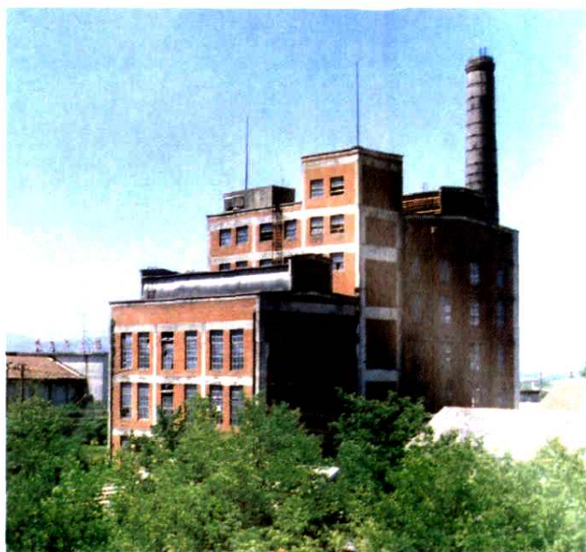
汤溪火力发电厂
