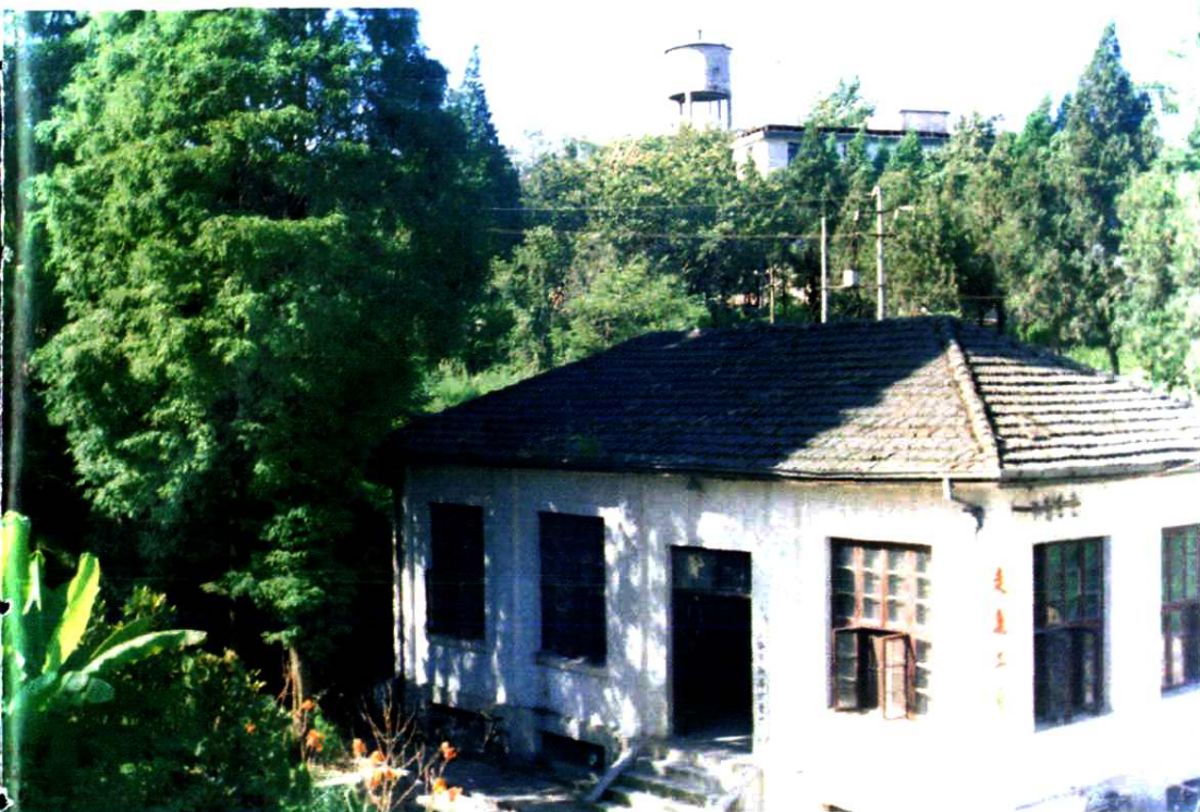
金华电网第一座水电站——金华湖海塘水电站
