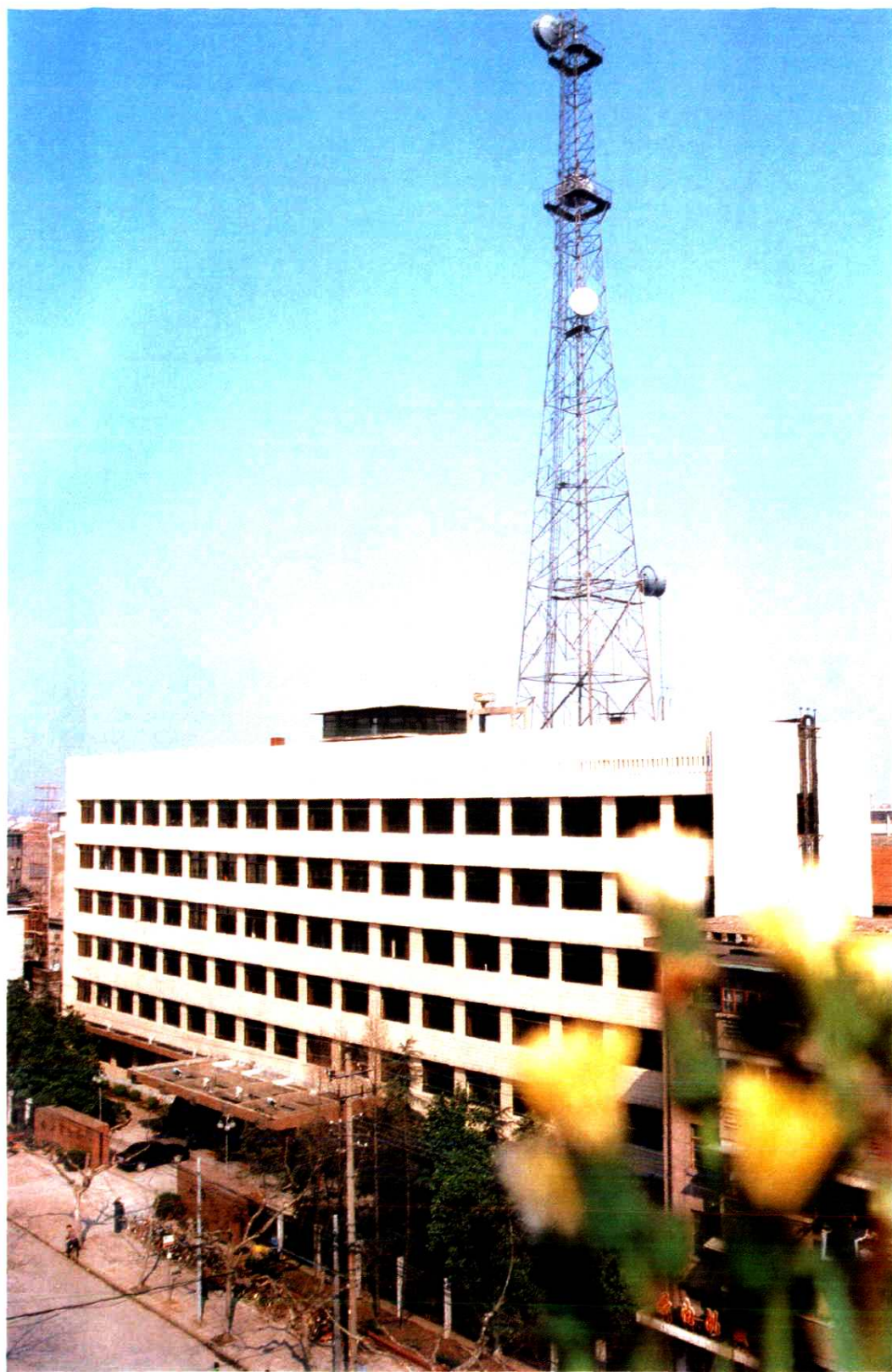
金华电业局调度办公大楼
