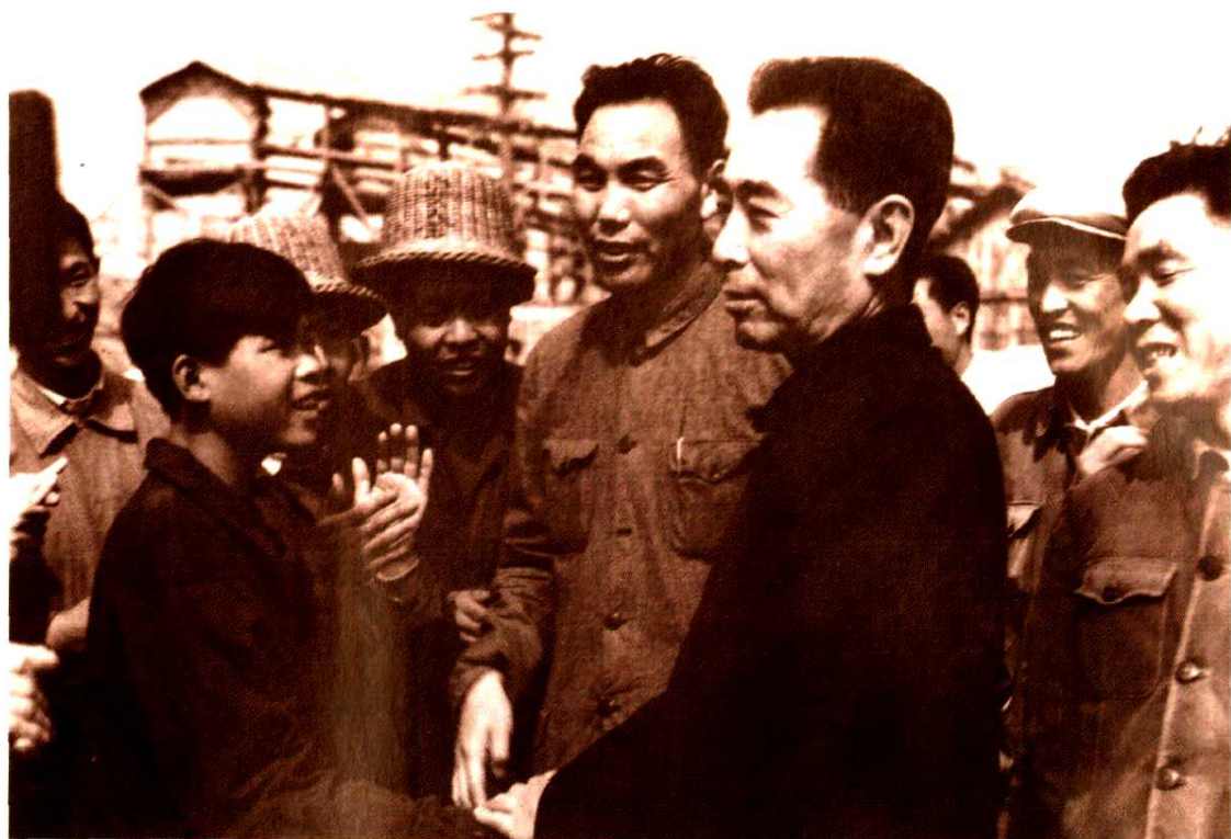
1959年4月9日周恩来总理视察新安江水电站建设工地
